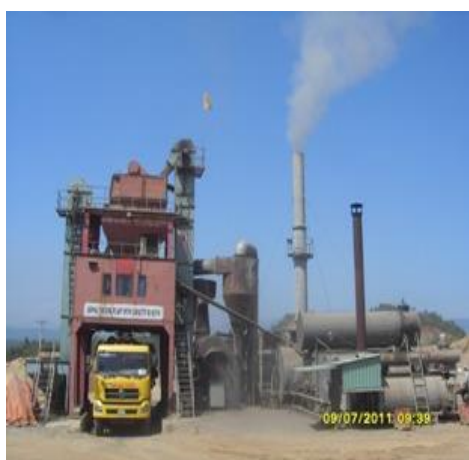
Xe vào nhận bê tông tại trạm trộn
